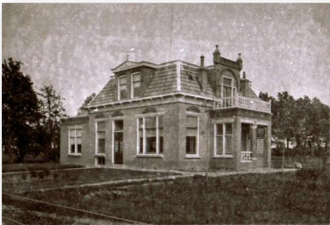
Gemeentelijk monument De Ijnhof aan 't Oost 52 te Oosterwolde
